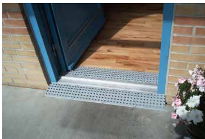
Rampe ohne Ecken in 1 Schicht.
