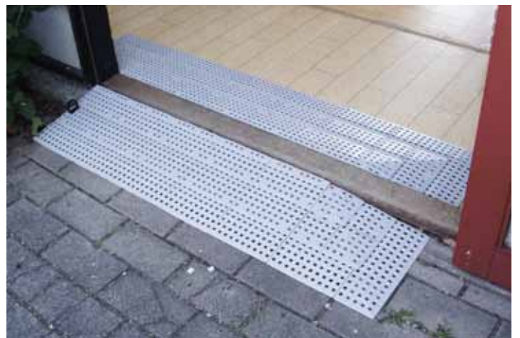
Rampe mit Ecken in 3 Schichten.
