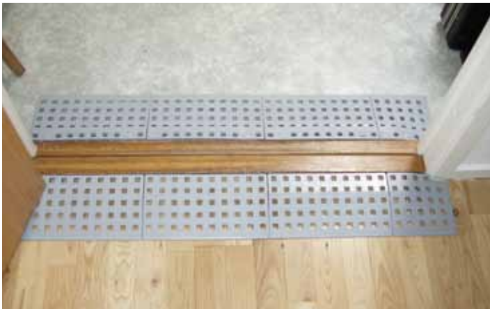
Innenrampe mit Ecken in 1 Schicht.
